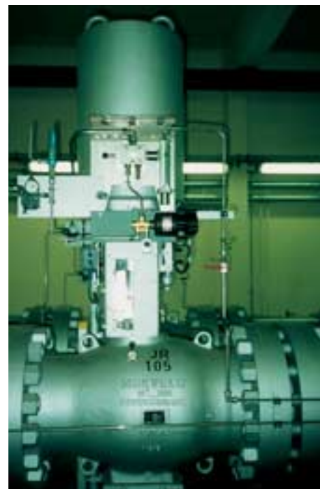
Предохранительный отсечной клапан 16" ANSI 600 на подземном хранилище газа, Германия
