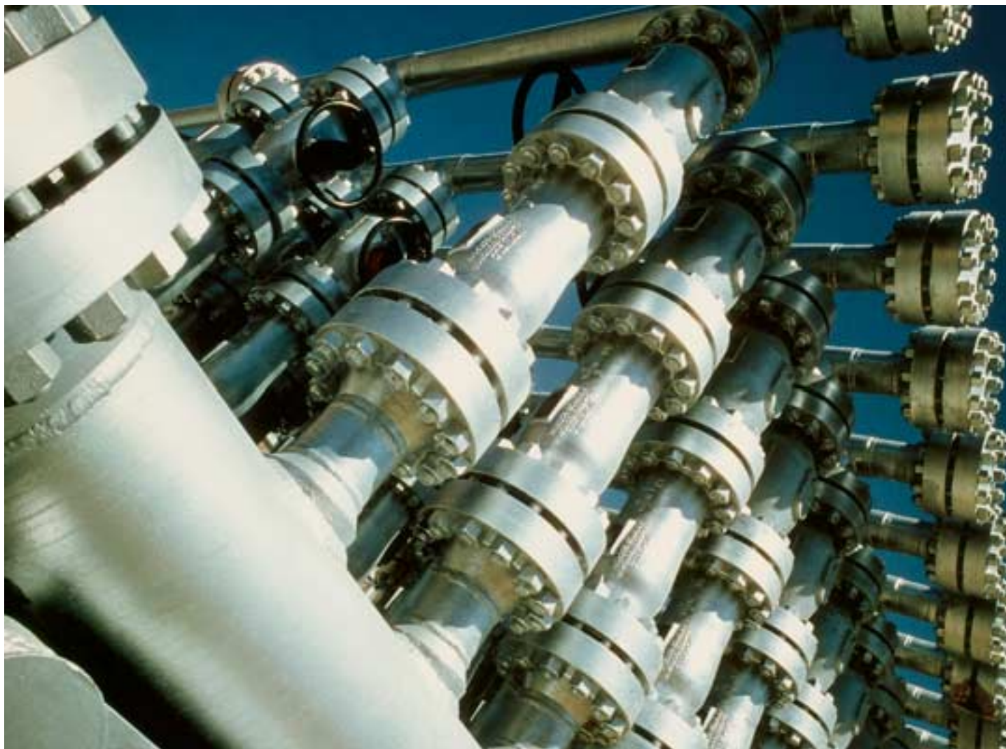
Отсечные и безударные обратные клапаны 6" ANSI 900 на коллекторе заправки воды в нефтяной пласт, северная Африка
